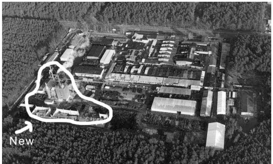
Weiter als bis zum Rohbau ist man bei dem Projekt „BRW 2000“ bislang nicht gekommen
